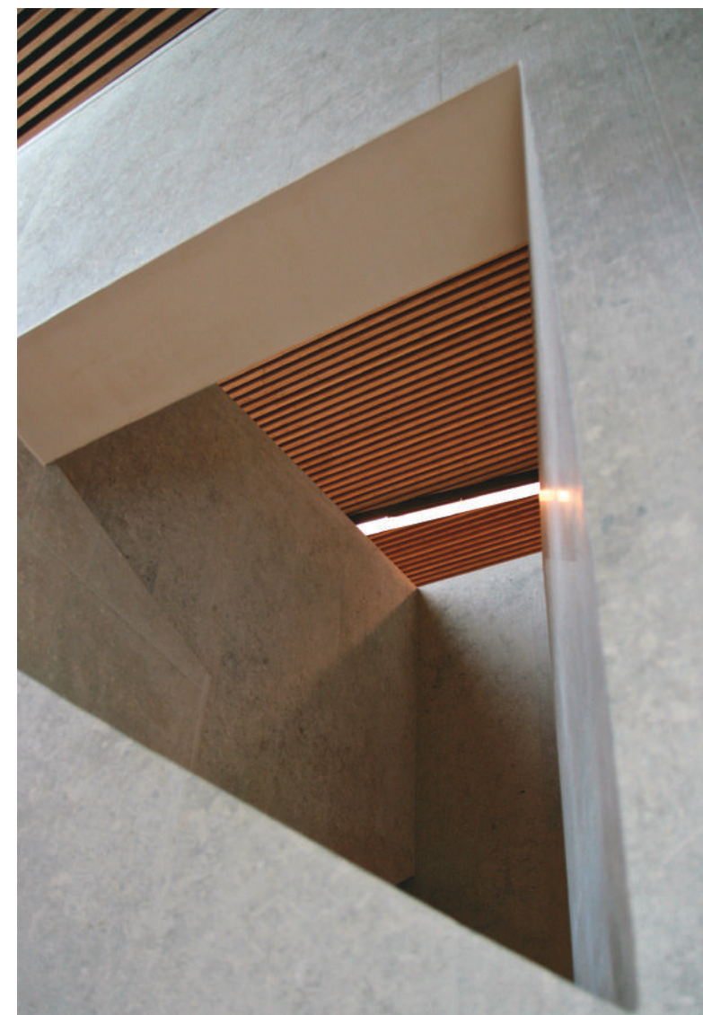
STRUTTURA IN CARTONGESSO RIVESTITA IN PIETRA
